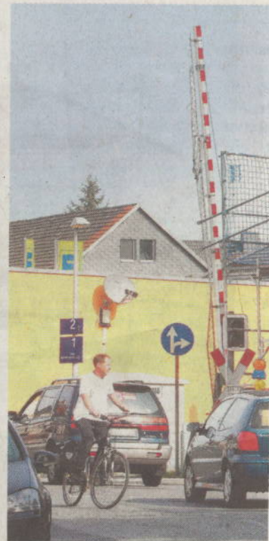
Im alten Glanz erstrahlt das Museumsstellwerk. Das Gerüst wird am Wochenende abgebaut.
